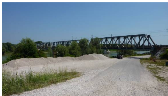
Il ponte sul Po di Borgoforte
