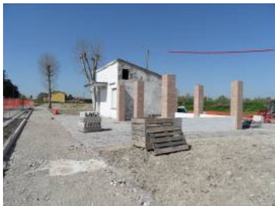
L'ex pesa pubblica di Nuvolato, in fase di ristrutturazione
