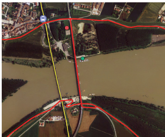
Ponte di Borgoforte
