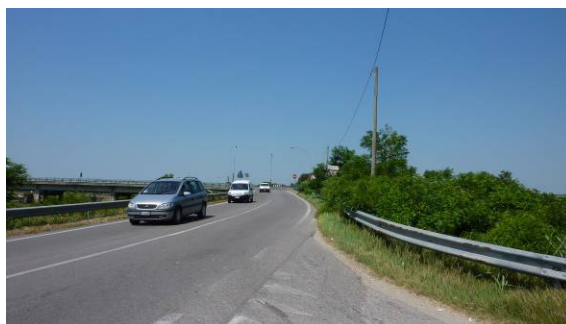
Strada di accesso verso il ponte; percorso protetto necessario
