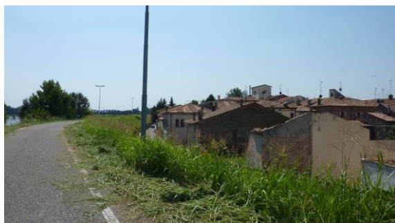
Tratto della ciclovia 2d che costeggia Revere; il tratto è utilizzato e arredato passeggiata urbana
