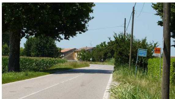
Fermata autobus tra Pegognaga e Zovo; situazione tipica sul bordo della strada da dove inizia una scarpata verso il canale: creare uno spazio sicuro per aspettare l'autobus e per salire/scendere
