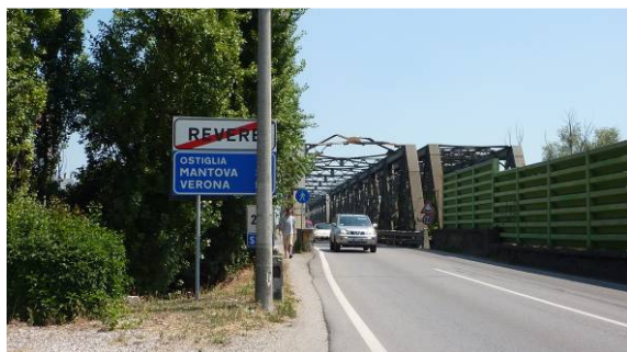
Il ponte sul Po Revere / Ostiglia
